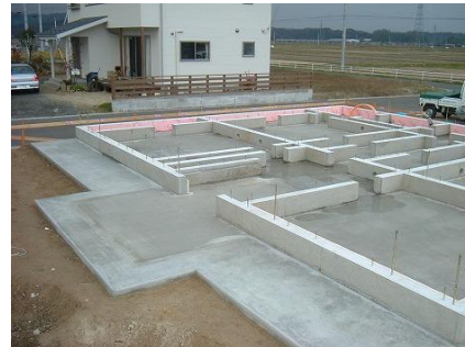
▲基礎全景 犬走り一体型ベタ基礎工法
