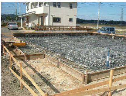
▲基礎全景 犬走り一体型ベタ基礎工法
