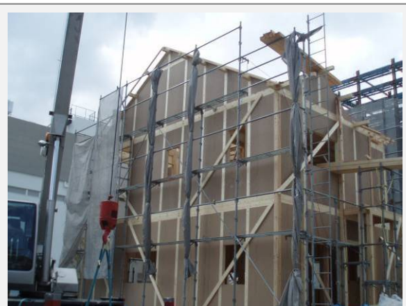
木造軸組+羽柄材 (パネル)
