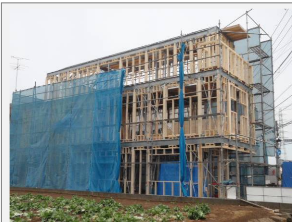
軽量鉄骨+羽柄材 (パネル)
