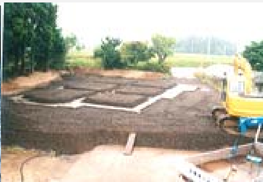
地盤改良の全体の様子
