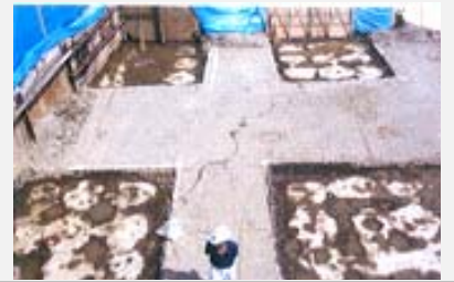
宅地全体を8.5m地耐力地まで地盤改良の様子
