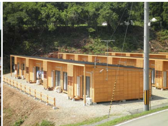
上：当グループ構成メンバーの設計・施工による地域材を活用した木造応急仮設住宅（南三陸町歌津）
