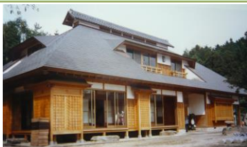
越屋根付寄棟の家
