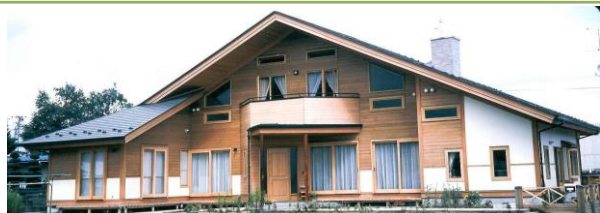
大屋根の家（3世代住宅）
